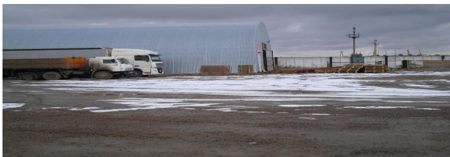
Рис. 1. Территория ТОО «LS Kokshetau» готова к размещению дополнительного оборудования Fig. 1. The territory of «LS Kokshetau» LLP ready for additional equipment
